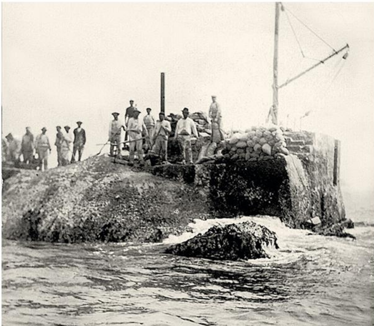
Le chantier du phare de Kéréon sur la « roche hargneuse », au Sud-Est de l'île d'Ouessant. Fernand Crouton conduira les travaux à partir de 1909 et faillira y laisser la vie deux ans plus tard. Entre-temps, un mécène s'est manifesté, qui a conduit à modifier le projet : la tourelle en béton à feu automatique initialement programmée va se métamorphoser en un phare habité en pierres de taille. © DDE 29
