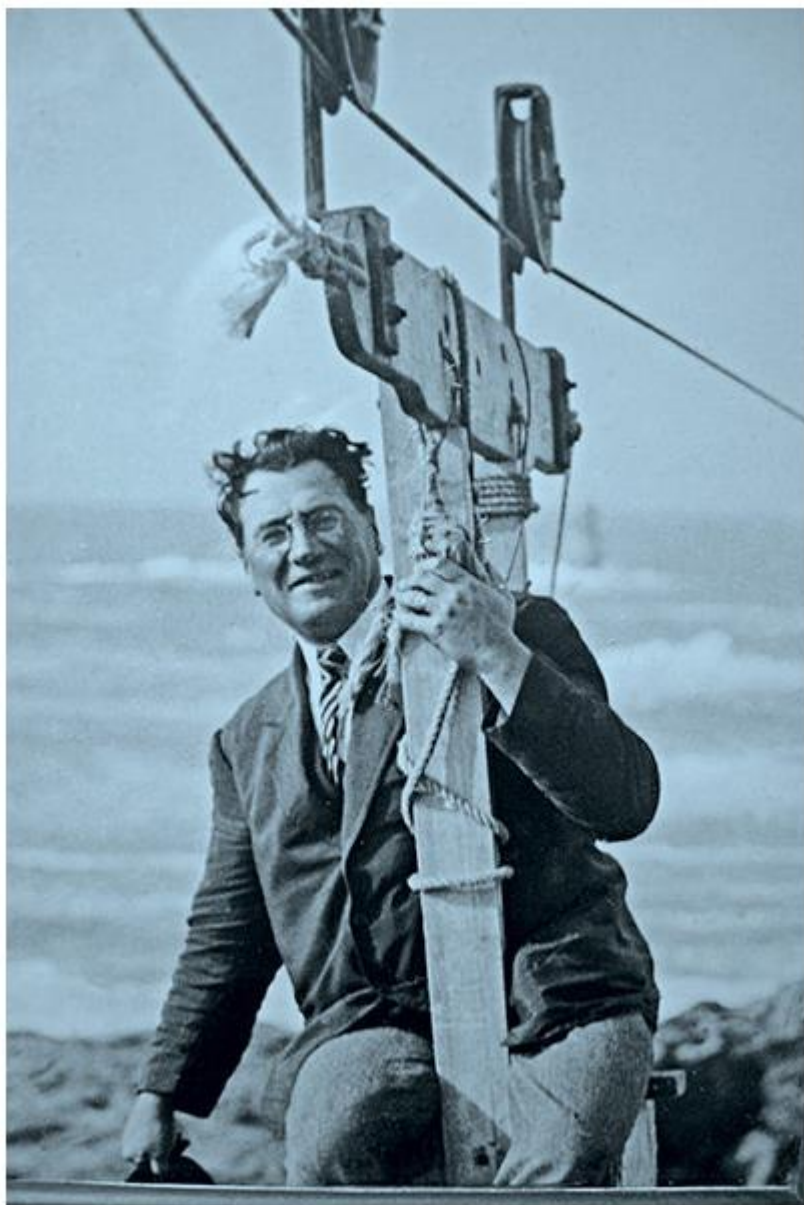
Fernand Crouton en 1923, dans la benne du va-et-vient du Nividic dont il conduit les travaux. Entamée en 1912, cette tour-balise en béton, érigée sur un écueil à l'Ouest de l'île d'Ouessant, sera achevée en 1930. © coll. Daniel Crouton/albums
